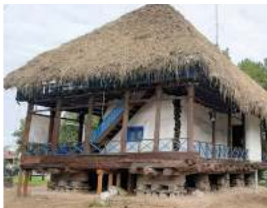
تصویری از یک ساختمان با سقف گالی پوش
