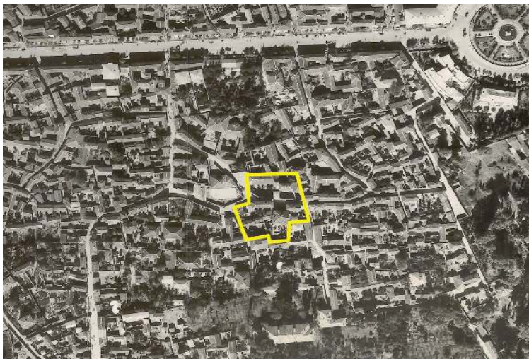
موقعیت کل مجموعه مسکونی بهاء‌الاطباء (خانه بردبار) قبل از تفکیک و تجزیه (عکس هوایی شهر گرگان- ۱۳۳۶ خ)
