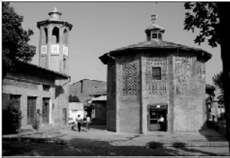
ساختمان امامزاده نور گرگان که برخی از آثار باقی مانده در آن مربوط به عصر تیموری است.
